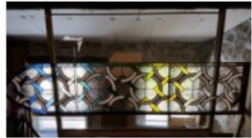
visuel d'ensemble de la baie en atelier avant la mise en masticage des panneaux.
