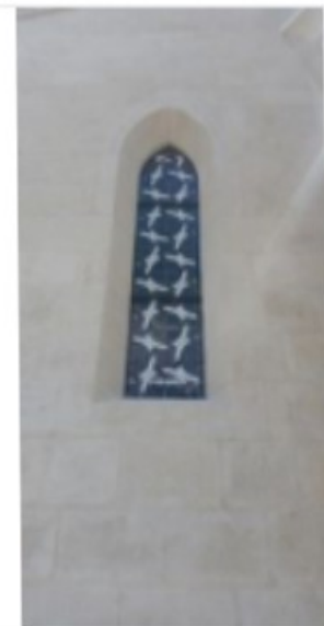
nouvelle baie vue de l'extérieur
